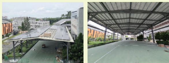
圖1：光電運動場目前光電屋頂施工現況
